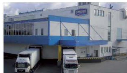
Молочный завод Danone, Чехия Системы сбора и отвода стоков
